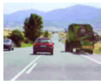
Marcas longitudinales continuas adosadas a discontinuas
