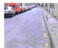
Marca amarilla longitudinal discontinua
